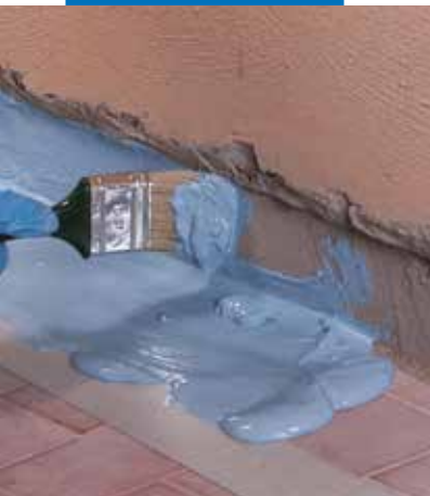
Application au pinceau, de Mapelastic AquaDefense à la jonction sol/mur, avant l'application de Mapeband
