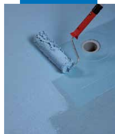
Application au rouleau de la seconde passe de Mapelastic AquaDefense
