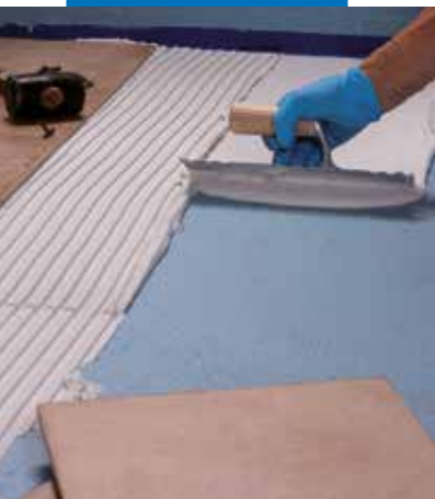
Collage des carreaux sur Mapelastic AquaDefense
