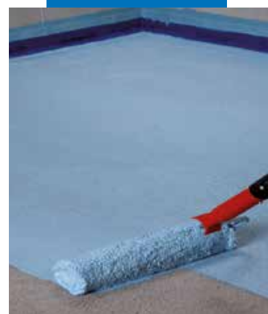
Application de la première passe de Mapelastic AquaDefense sur chape
