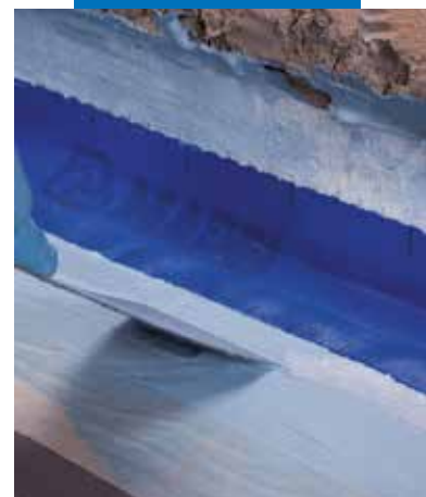
Application de Mapeband dans la jonction sol/mur avec Mapelastic AquaDefense
