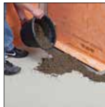
=> 5. Réaliser la chape avec forme de pente
