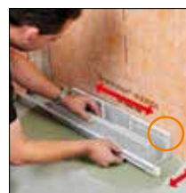
=> 1. Ajuster le support de caniveau
